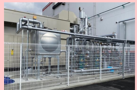
（参考）大門工場に設置されたコージェネレーションシステム
